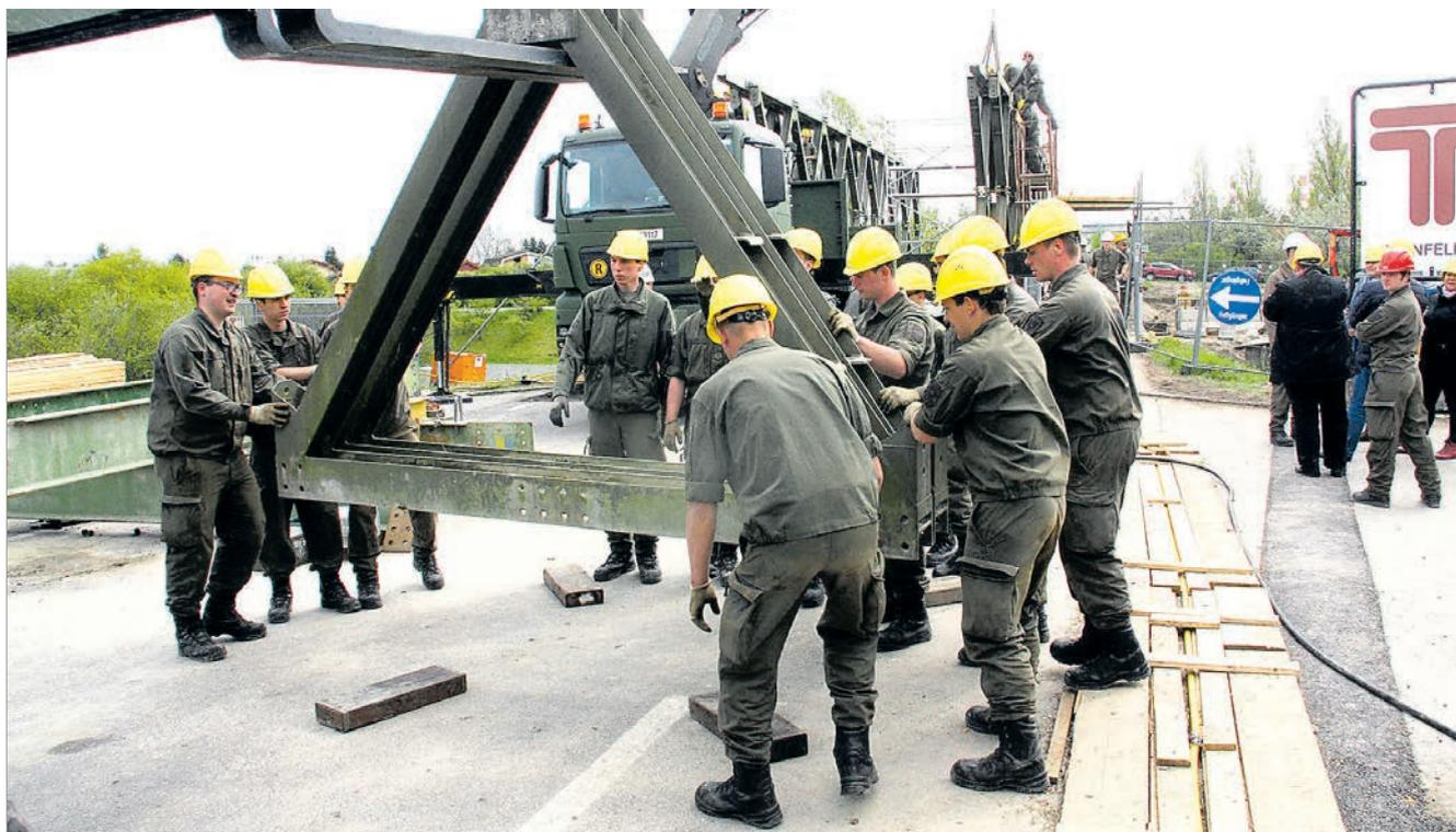
*Spektakulärer Einsatz in Mannswörth: Die Soldaten der technischen Kompanie aus Melk befestigen einen Teil des Tragwerks für die provisorische Brücke am Kran.*
